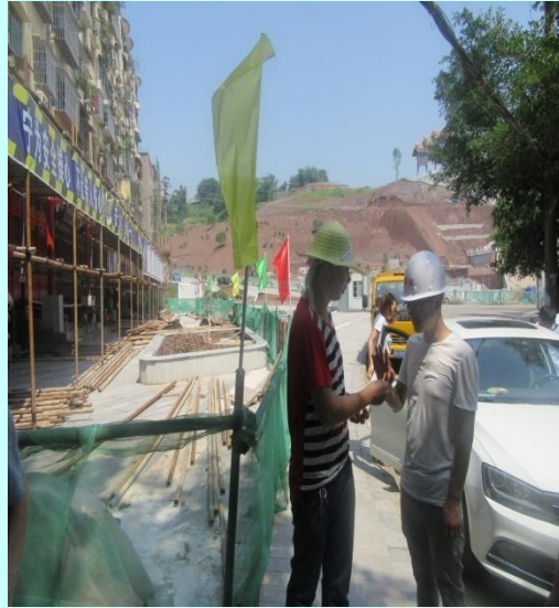
质安部检查施工现场
