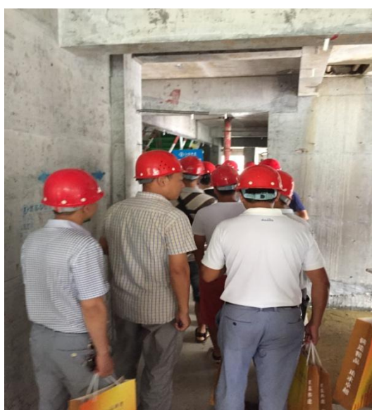
总工程师、质安部及 各项目经理观摩标化工地
