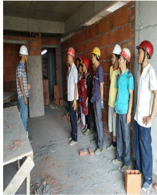
荃城西区城中村改造项目 章广二期城中村班前会
